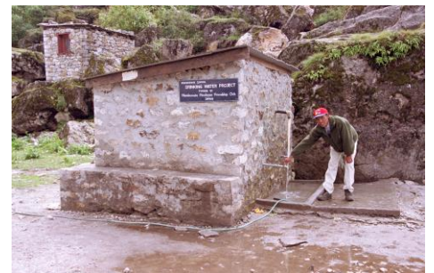
600m水道引込みと貯水槽
