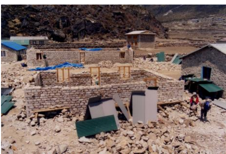
建設中の学生寮
