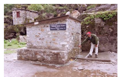
600m水道引込みと貯水槽
