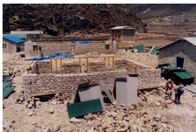
建設中の学生寮
